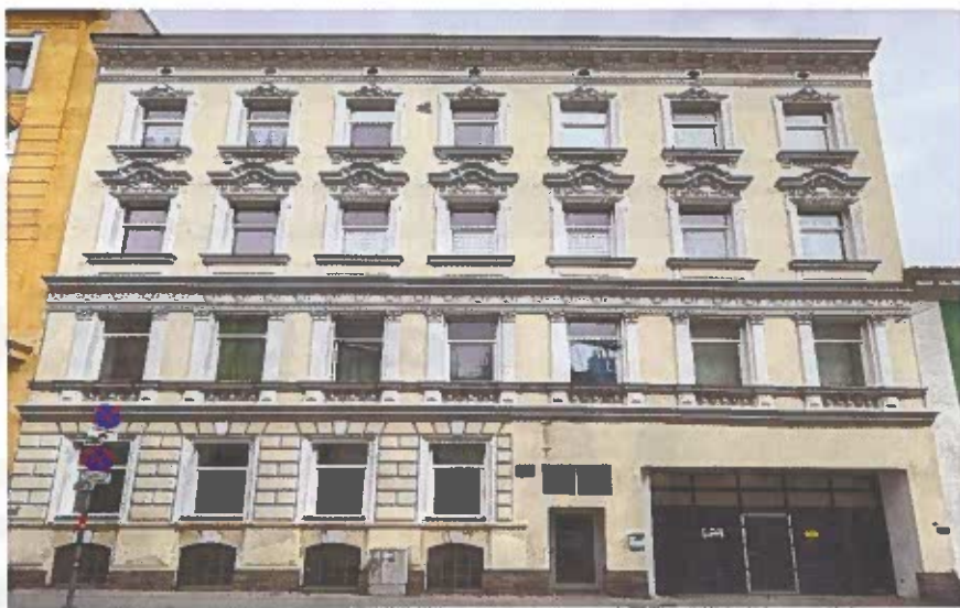
Zinshäuser starten in Wien bei rund zwei Millionen Euro Kaufpreis, so wie dieses Gebäude mit zehn Wohnungen in Ottakring, das von Plenus Immobilien angeboten wird.
